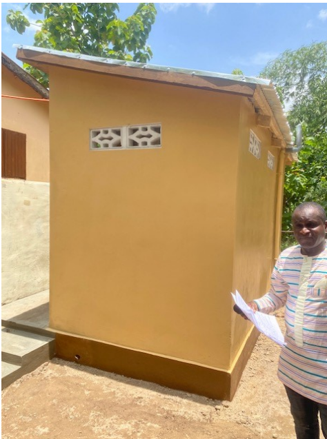
Der Schulleiter freut sich über die neue Anlage
